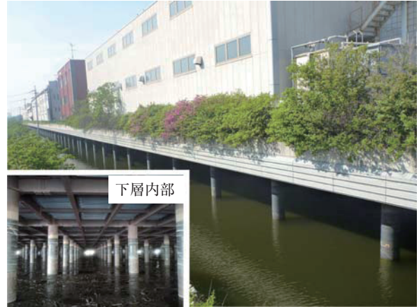
写真4 埼玉県南卸団地の人工地盤
