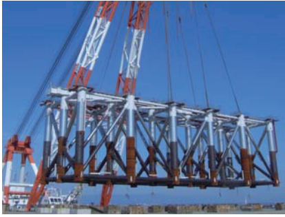
写真3 東京国際空港D滑走路誘導路のジャケッ ト
